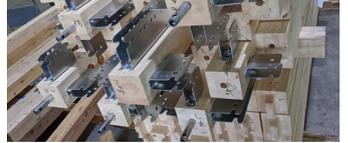
↑殆どの工務店、ハウスメーカーはこのように大きく柱を削ってしまいます。従来の「木軸工法とエースホームの金物工法」違い、わかりますよね?
