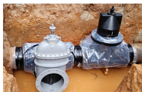
既設の水道管から分岐し、 新しい水道管を布設していきます!
