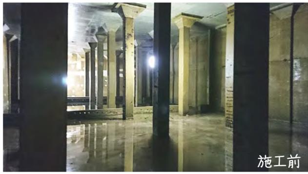
ここが何処だかわかりますか? まるで地下神殿ですよ。田原市内のとある貯水施設の中です。水槽内部を特殊工法により防水処理をして、老朽化した施設を再生しています。
